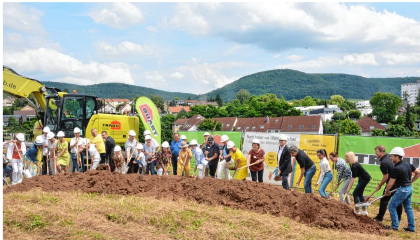
Schon beim Spatenstich legten viele fleißige Hände gemeinsam los.
